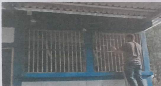
Foto 5: SUSTITUCION DE BALCONES DE METAL
