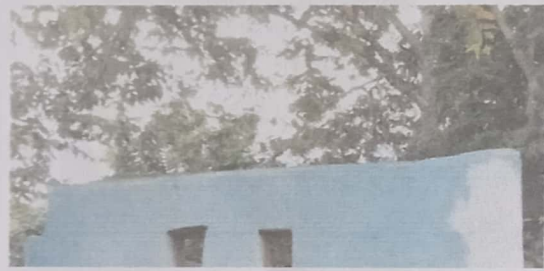
Foto 2: SUSTITUCION DE LAMINA POR LAMINA GALVANIZADA EN COCINA
